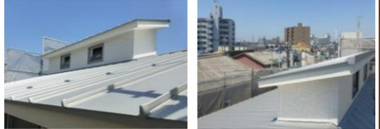
この風光塔です。上部で風を流すことで室内の空気を引き上げ1階北側の地窓からの涼しい空気を引っ張り上げる効果があります。実際に実験すると、みごとに宙に浮かんでいる風船が動きだし、風光塔の窓から吸い出されました。5回に渡ってお伝えした研修報告ですが、まとめると基本は断熱・気密をきちんと高めることで効率のいい換気ができ、室内の空気がきれいになる。そして、自然の恵みをうまく利用することで、真冬や真夏以外はエアコンに頼らない快適な暮らしをつくりエアコンを使う時期でも少しのエネルギーで冷暖房を維持できる。
